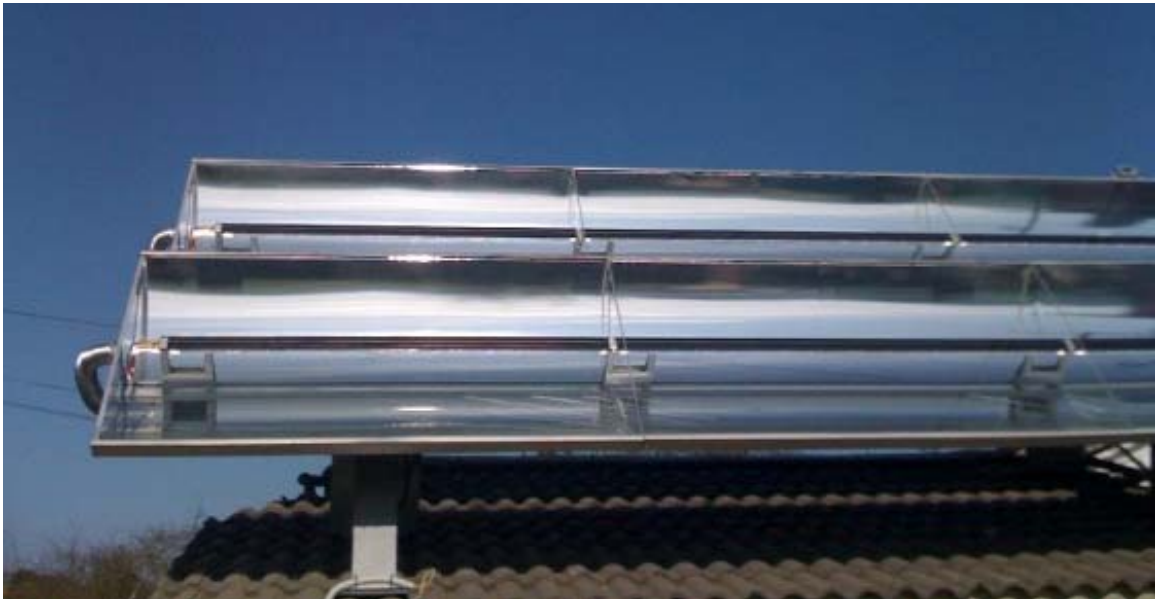
Figur 5. Solfångare kombinerad med solceller. Källa: Absolicon
